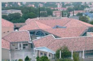
Acabamento com elementos pequenos (telhas).
