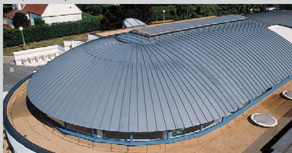
Piscina de Guyancourt (78)
