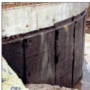
O isolamento FOAMGLAS® READY BOARD é aplicado numa parede arredondada de suporte.
