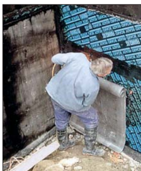
Soldagem da membrana impermeabilizante no isolamento FOAMGLAS® READY BOARD.
