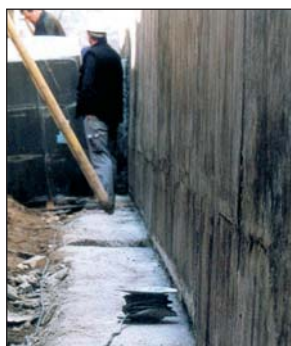
Invólucro em betão estanque. O isolamento é realizado com placas FOAMGLAS® S3 de 8 cm.
