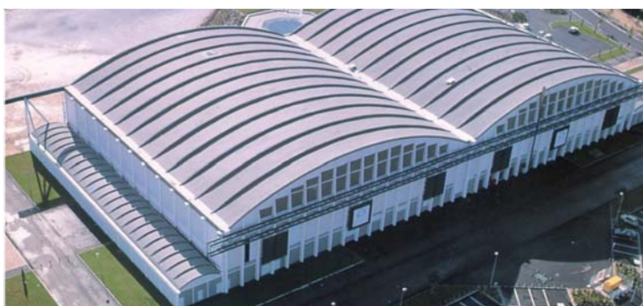
Renovação e transformação de um antigo hangar aeronaval em piscina (Étang de Berre)
